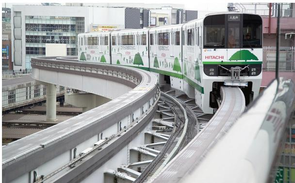
**Abb. C-7** Unabhängiger Bahnkörper für Einschienenbahnen (Lizenz: Public Domain)
